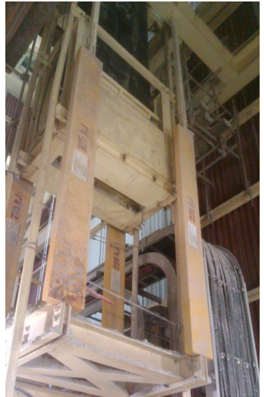
Vista de Technogrids® y del armazón de sostenimiento en la parte inferior de la instalación.
