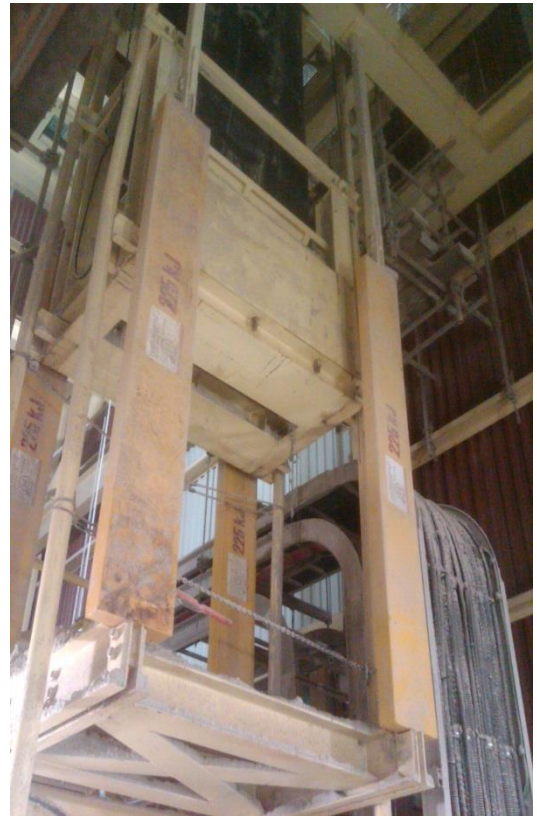
Plan du Technogrids® et du cadre de rupture vus d'en dessous de l'installation
